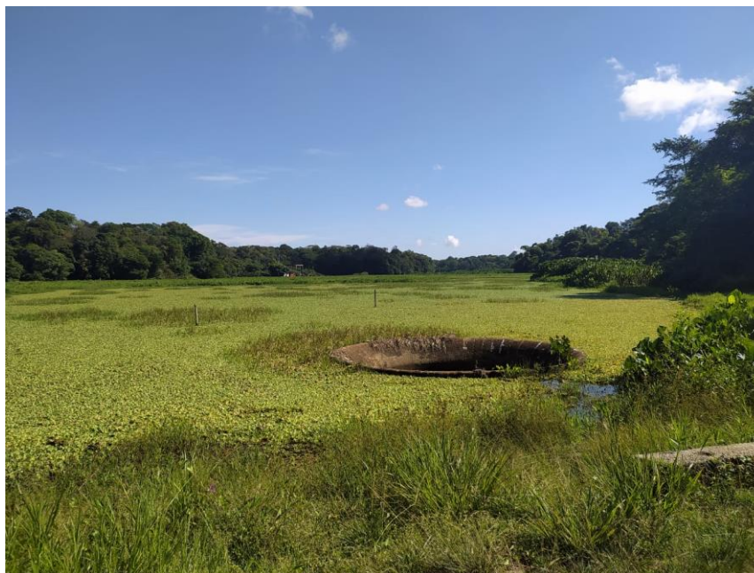
Figura 11: Extravasador de água do lago Bolonha.
